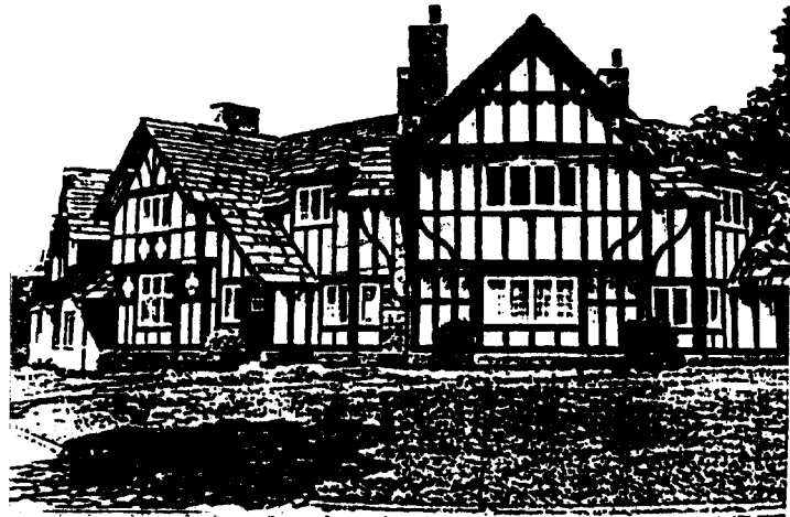
Figura 3a: Casas del camino bajo Fuente: UML Information Services, Port Sunlight, 1988
